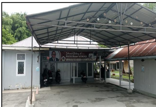
Gambar 1. Bangunan Program Vokasi UNG
