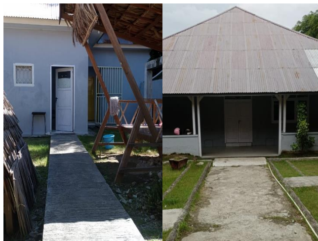
Gambar 6. Akses menuju ke Pantry/Dapur dan Toilet dari Ruang Teknik Rekayasa Energi Terbarukan (TRET) dan akses ke Ruang Aula Serbaguna
