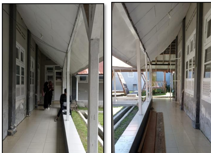
Gambar 4. Selasar menuju Lab. Komputer Teknik Rekayasa Perangkat Lunak (TRPL) dan ke Ruang Teknik Rekayasa Energi Terbarukan (TRET)
