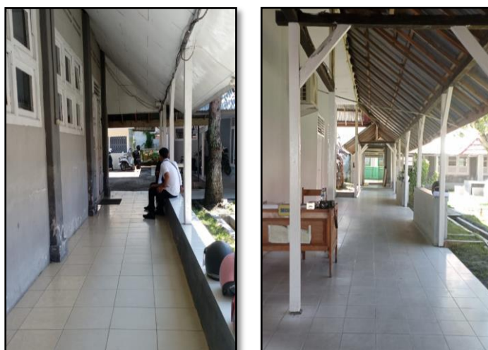
Gambar 5. Selasar menuju ke ruangan Direktur dan ke Ruang Kuliah Arsitektur Bangunan Gedung (ABG)
