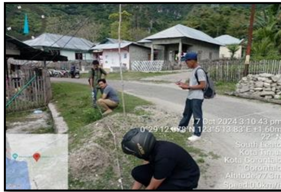
Gambar 1. Pengukuran Titik Perencanaan Drainase di RT 002/RW 004
