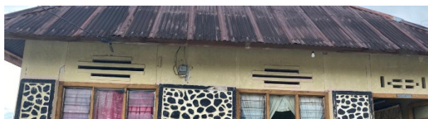
gambar 4 Ventilasi horizontal di atas bukaan pintu dan jendela Rumah Bapak Rukhmin Toniode.
